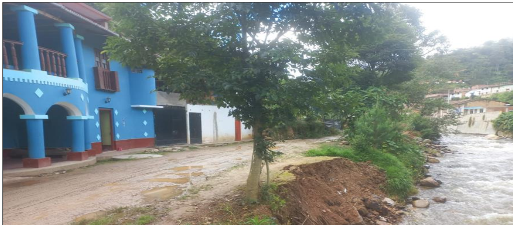
FIGURA N°02: SE OBSERVA EL MATERIAL COLMATADO EN EL CAUCE DEL RIO PANAÑO (RIO CHINCHAYCOCHA), LA EROSION DEL TALUD DE LA RIBERA EN AMBAS MARGENES.
